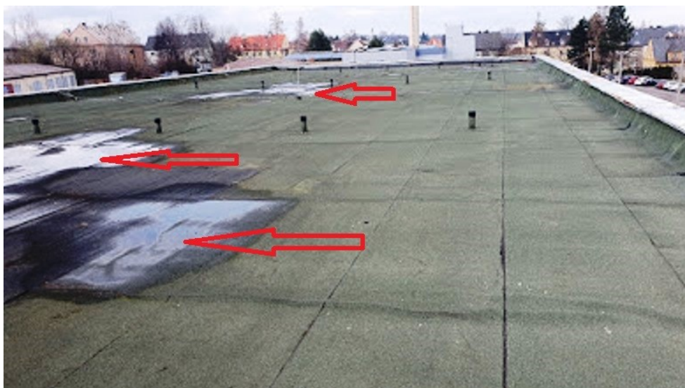
Obrázek č. 1 – celkový pohled na střešní plást, kde je zřejmé posuv ve vodorovném směru střešního pláště a vytváření kaluží.
