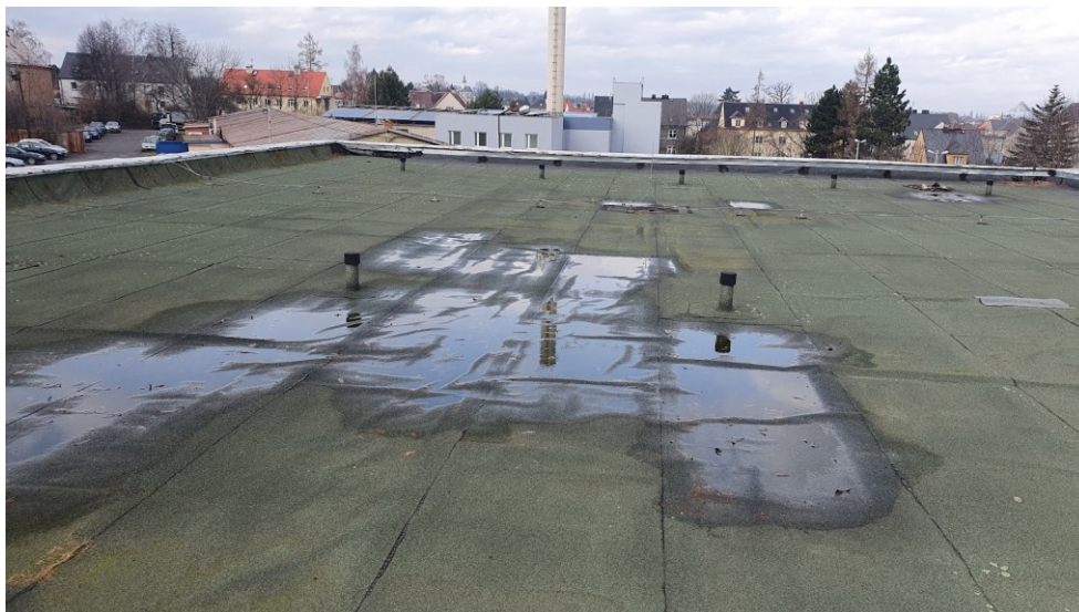
Obrázek č. 5 – deformace střešní krytiny SBS pásu
