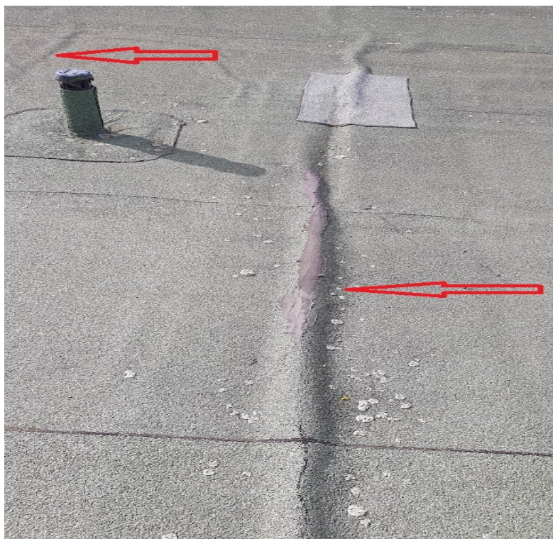
Obrázek č. 6 – deformace SBS pásu od atikové konstrukce
